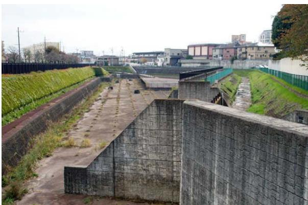
空堀川は直線化工事の真っ最中です。上の画像は右が旧河川、左は調節池です。ゲリラ豪雨で奈良橋川との合流点からあふれ出る流水を溜めて氾濫を防ぐために設けられています。直線化と並行しての工事のようです。
